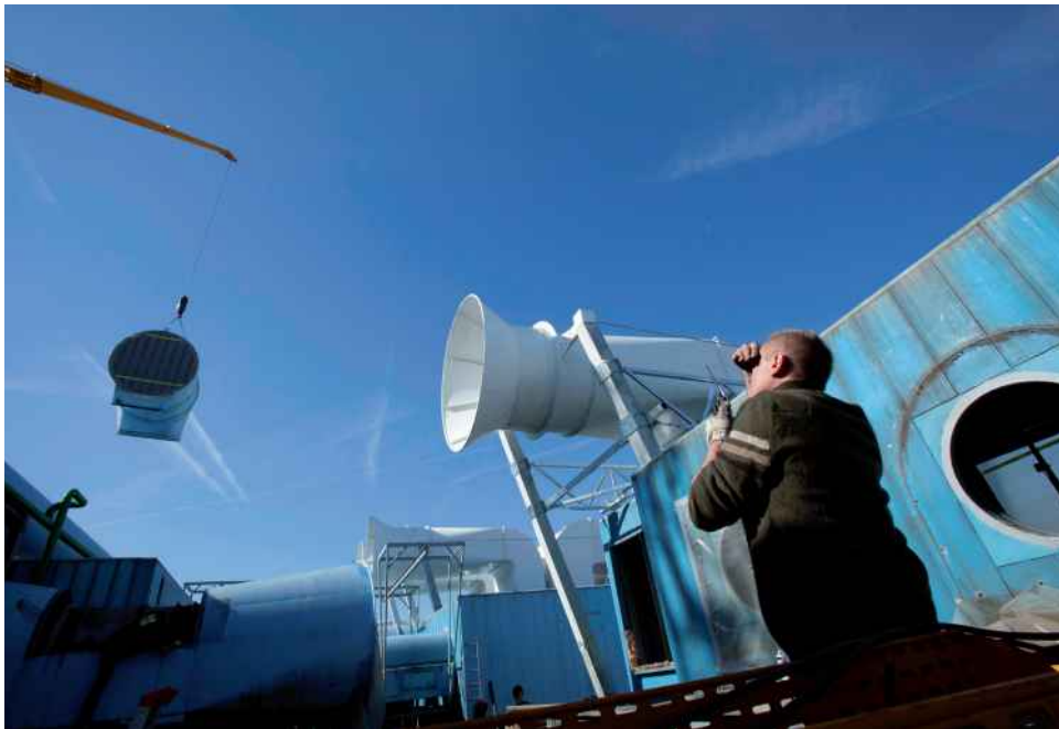
Au niveau 7, toit-terrasse, démantèlement des centrales de traitement d'air © Centre Pompidou / photo H. Véronèse
