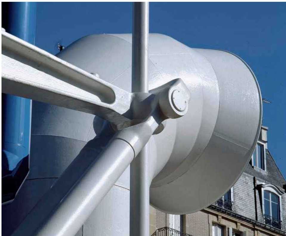
Détail de l'architecture du Centre Pompidou © Centre Pompidou.
